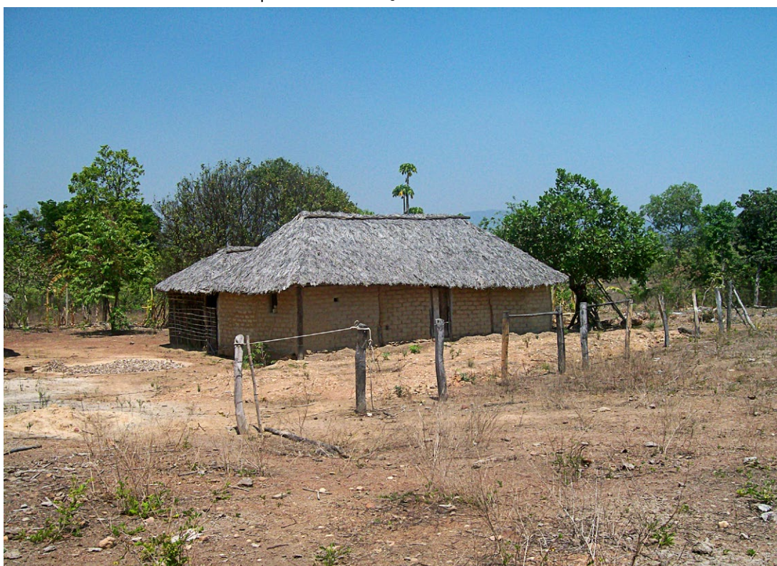
FIG 5 - Casa de Dona Lió após a restauração
