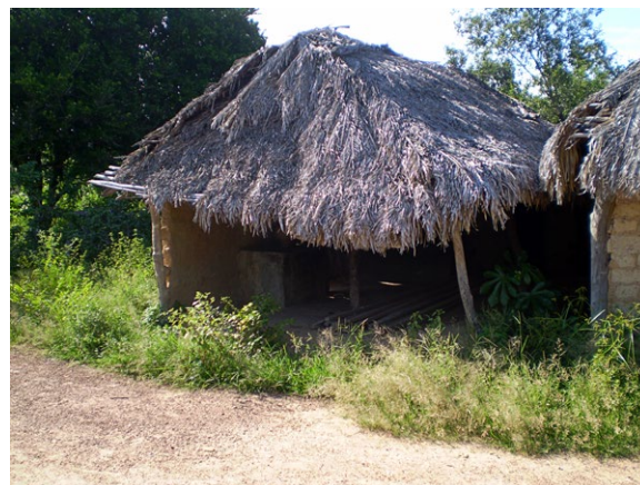
FIG. 2 - Casa de Dona Lió antes da restauração (registro lateral)
