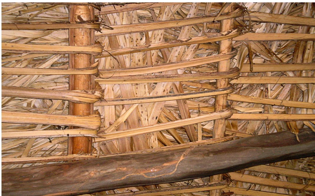
FIG. 4 - Trama tradicional da cobertura
