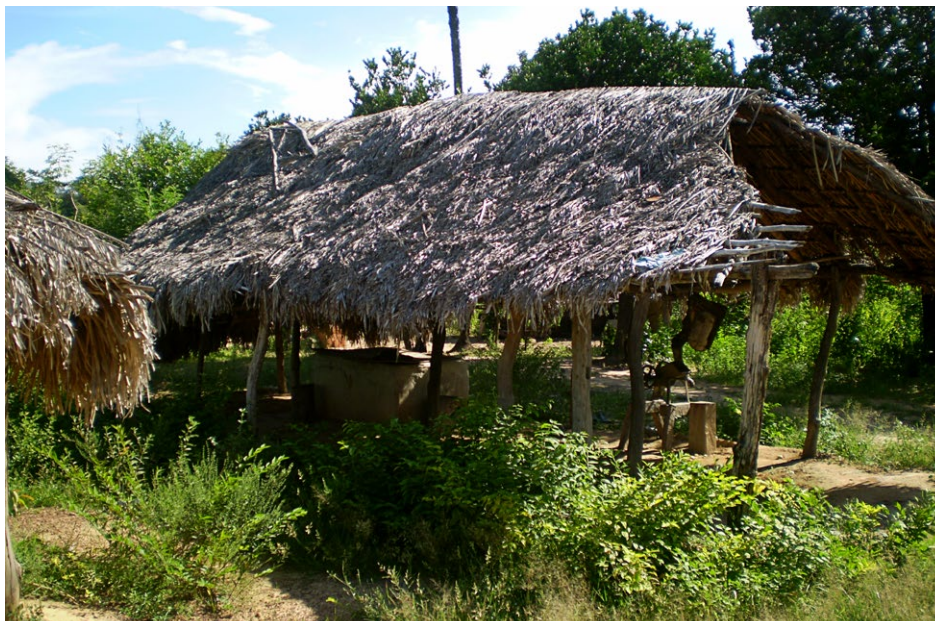
FIG. 3 - Casa de farinha e de preparação de biscoitos antes da restauração
