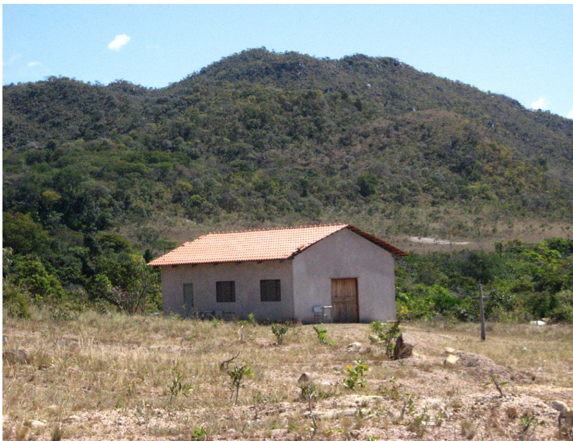
FIGURA 2 - Capela do Engenho II
